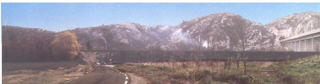
La Montagne de Saint Génès, traversée par le tunnel du TGV, isole le quartier des Ilons du reste du territoire.
