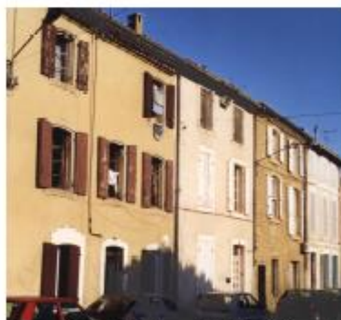
Les maisons de ville au bâti traditionnel
