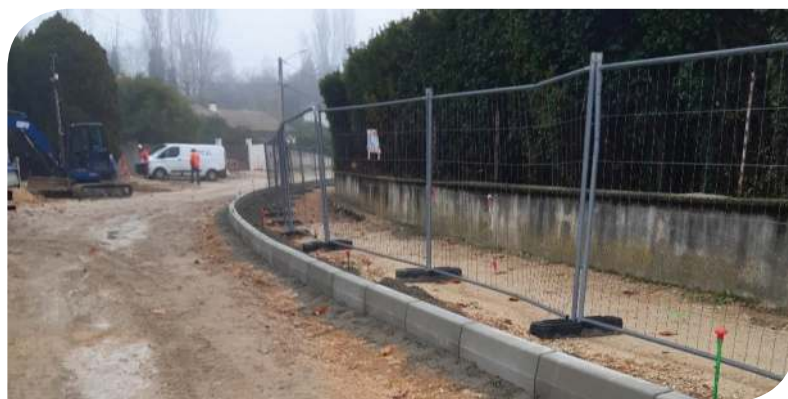
Travaux route d'Avignon
